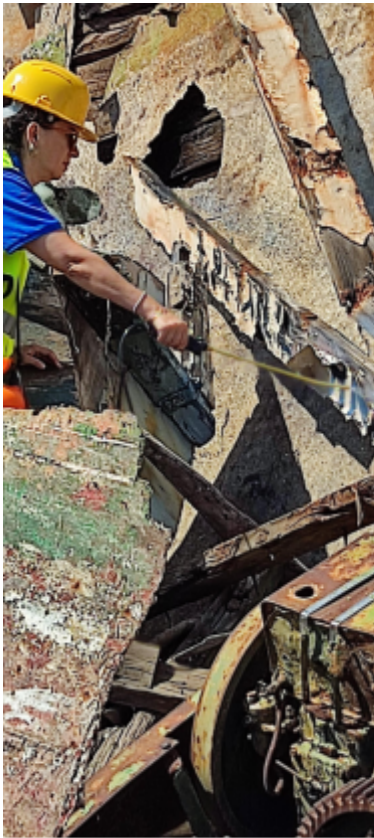
Εικόνα 3. Πρώτα σωστικά μέτρα: επιφανειακή στερέωση με τη μέθοδο του ψεκασμού
